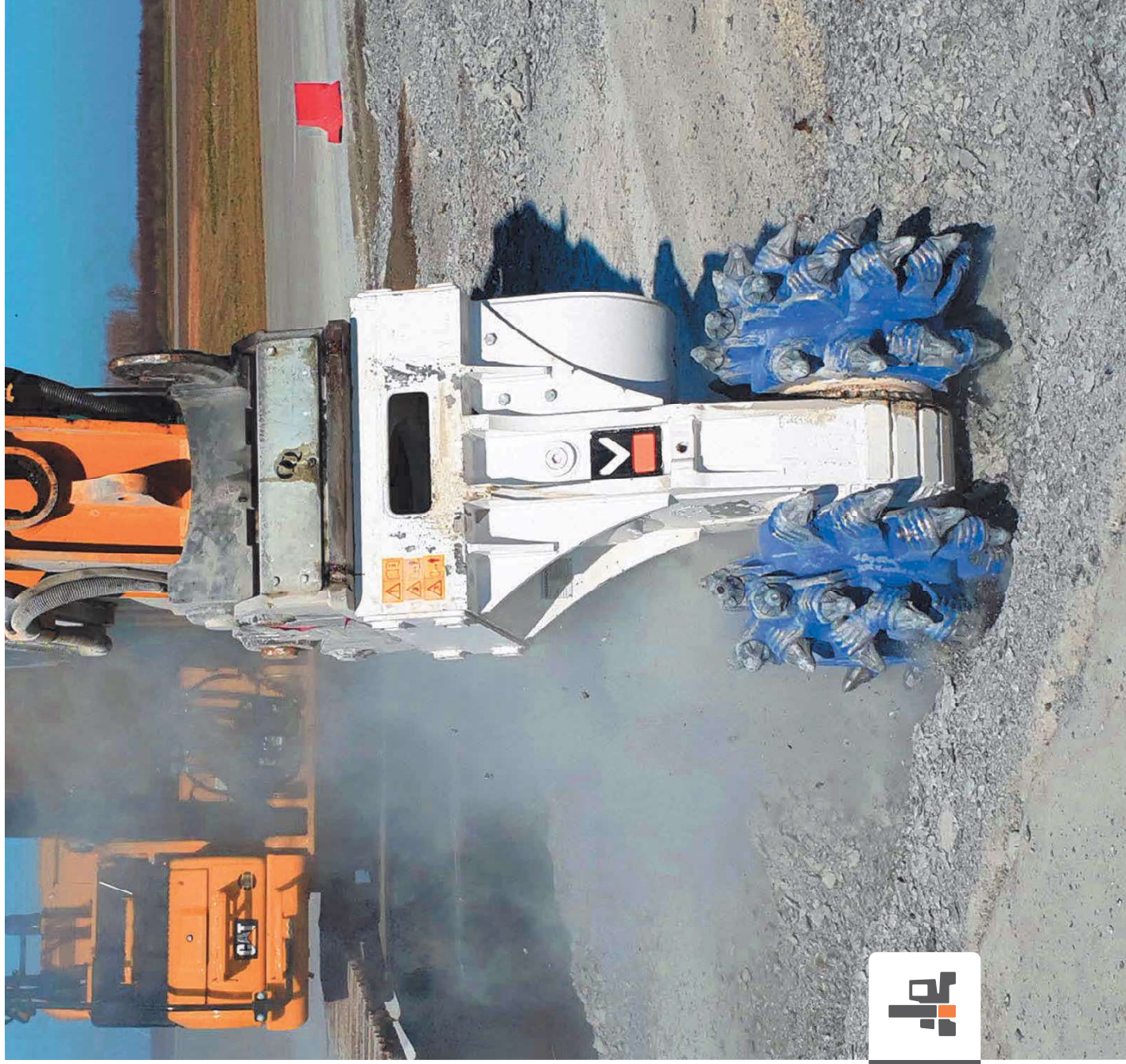
KR 150 Demolizione del calcestruzzo
